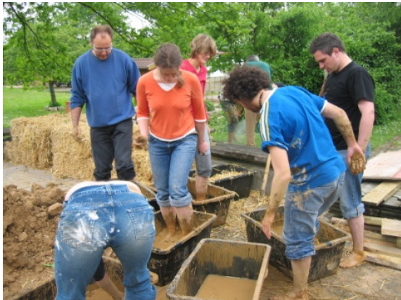
Auf der Baustelle
