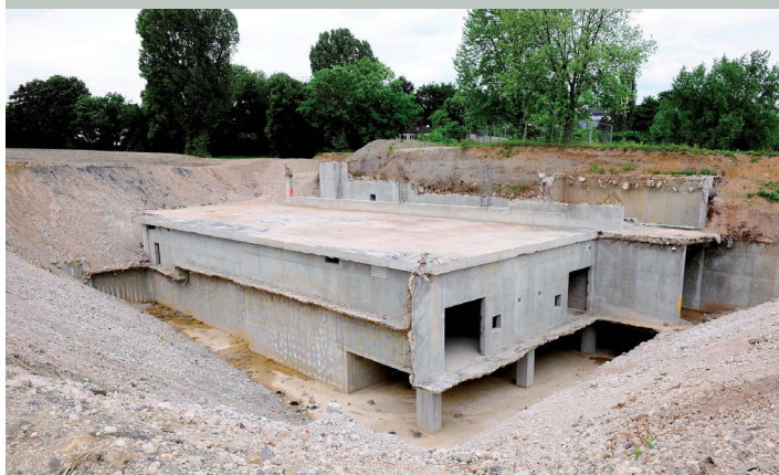
Zisterne im Rohbau
