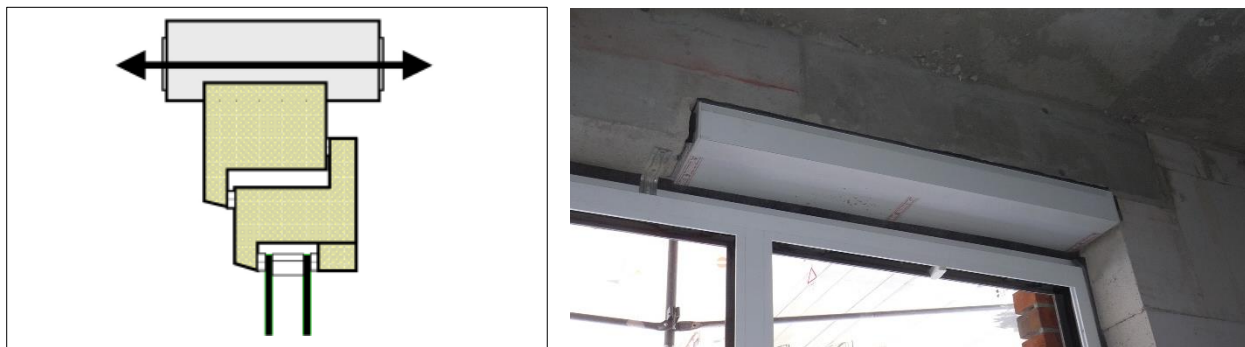
Abbildung 59: ALD als Aufsatzelement am Blendrahmen montiert, Quelle linke Abbildung ift Rosenheim
