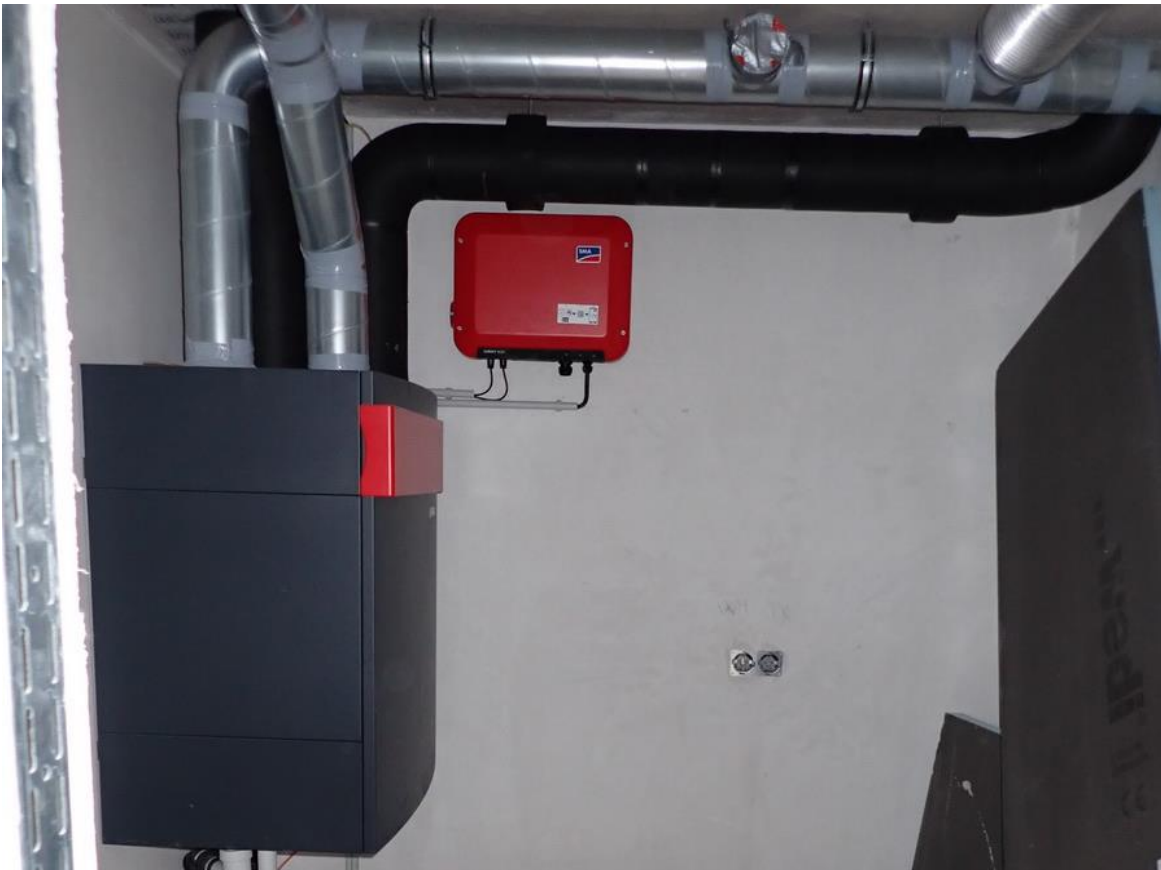
Abbildung 25: Wohnungszentrales Zu- / Abluftsystem mit Wärmerückgewinnung
